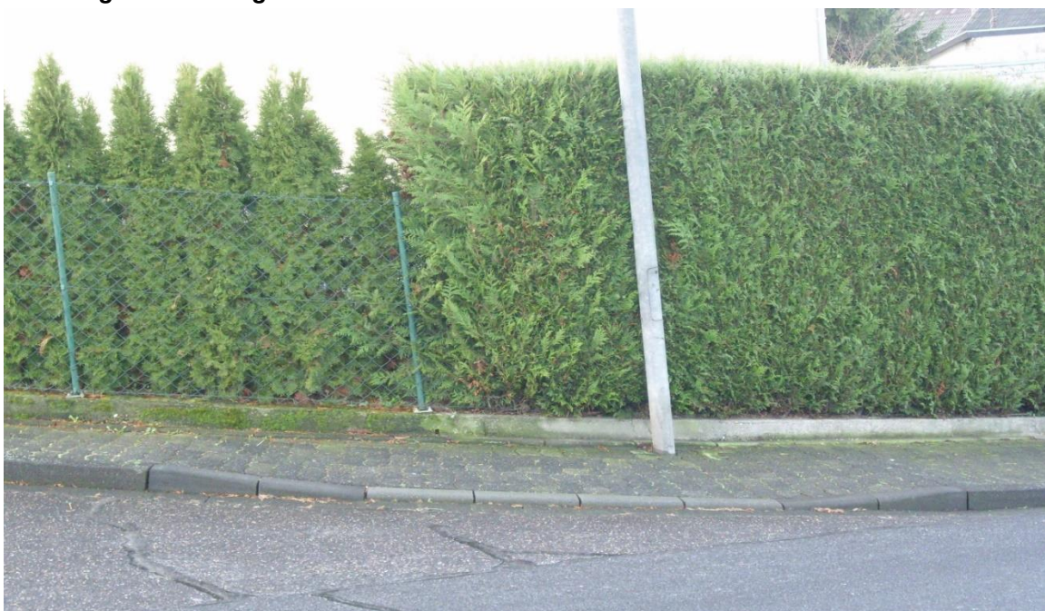
Gehwegabsenkung zur Straßenquerung
