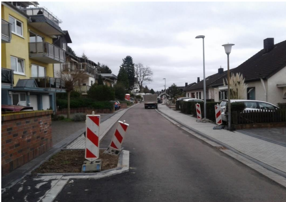
Fertiggestellter 1. Teilabschnitt mit neuer LED Straßenbeleuchtung
