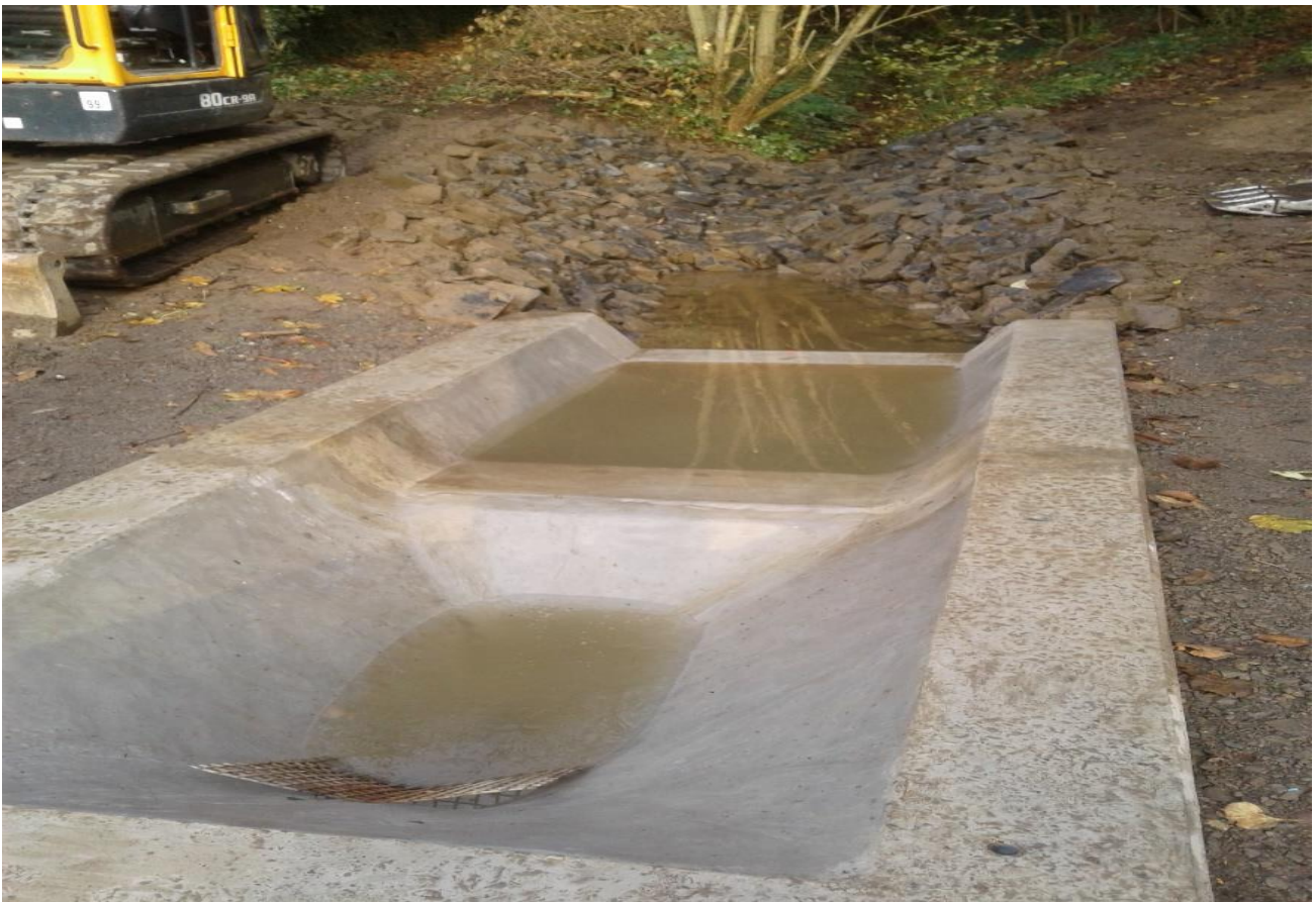
Erster Schritt Sandfang mit Absetzfunktion
