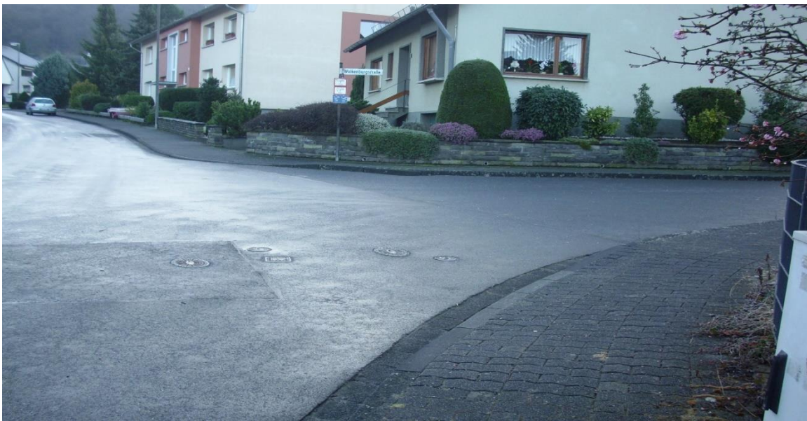
Gehwegabsenkung im Kreuzungsbereich
