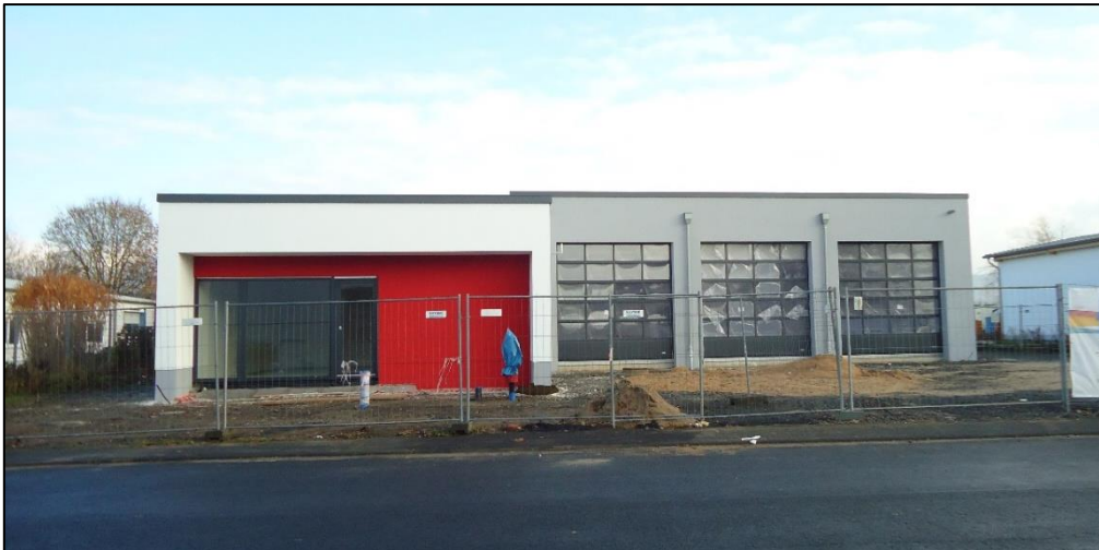
Straßenansicht Feuerwehrgerätehaus Bruchhausen
