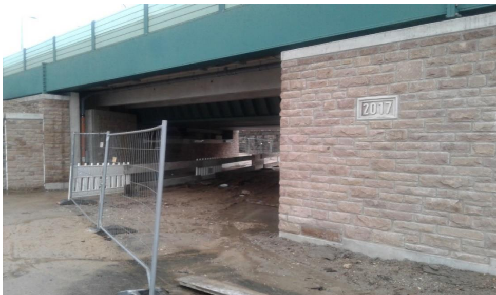
Bahnunterführung mit neuer Beleuchtungsanlage
