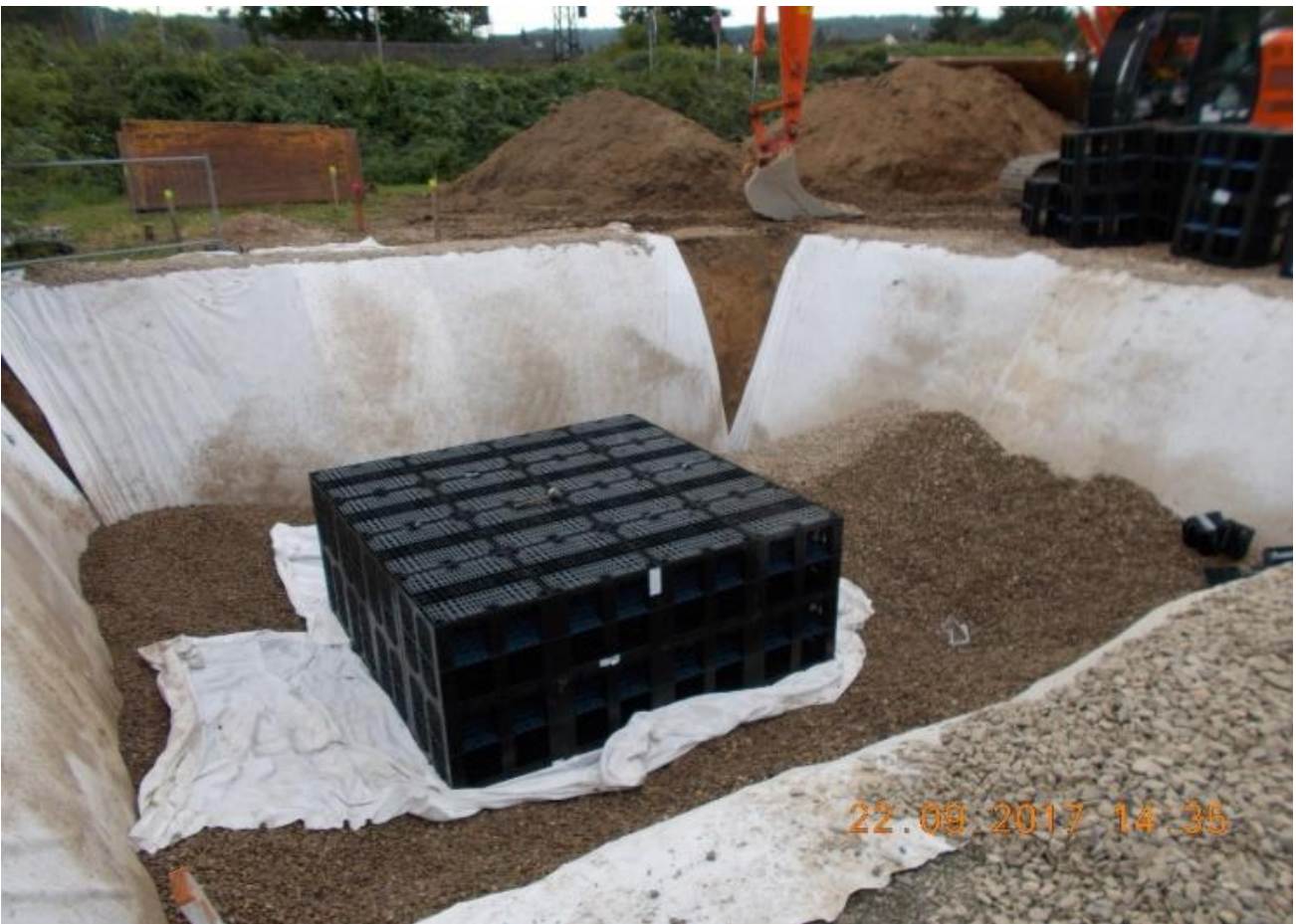
Versickerungskörbe mit Kiesauffüllung
